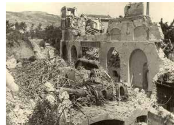
1944 - Situazione dopo uno dei 36 bombardamenti subiti (Archivio Franco Marulli)
