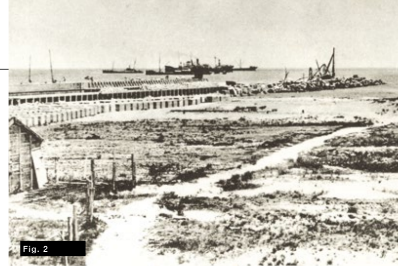
Fig. 2 Porto canale di Pescara: costruzione dei moli.
