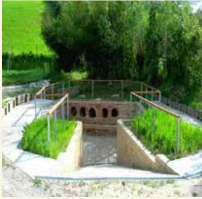
Fonte Barco appena dopo il restauro
