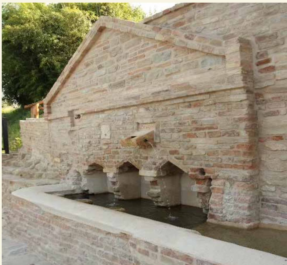
Fonte Locca con l'antica facciata restaurata.
